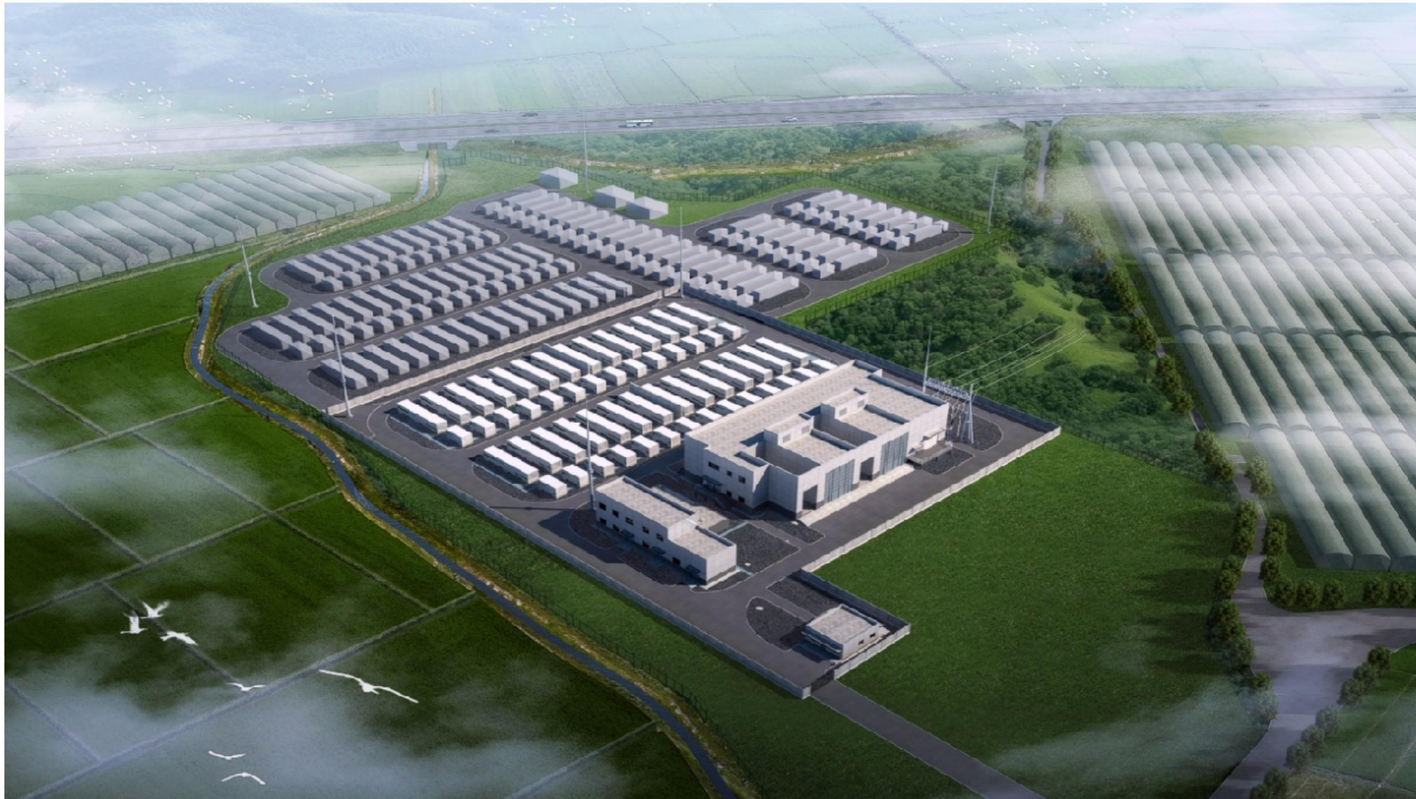
▲ 台州三门电网侧储能电站示范项目
