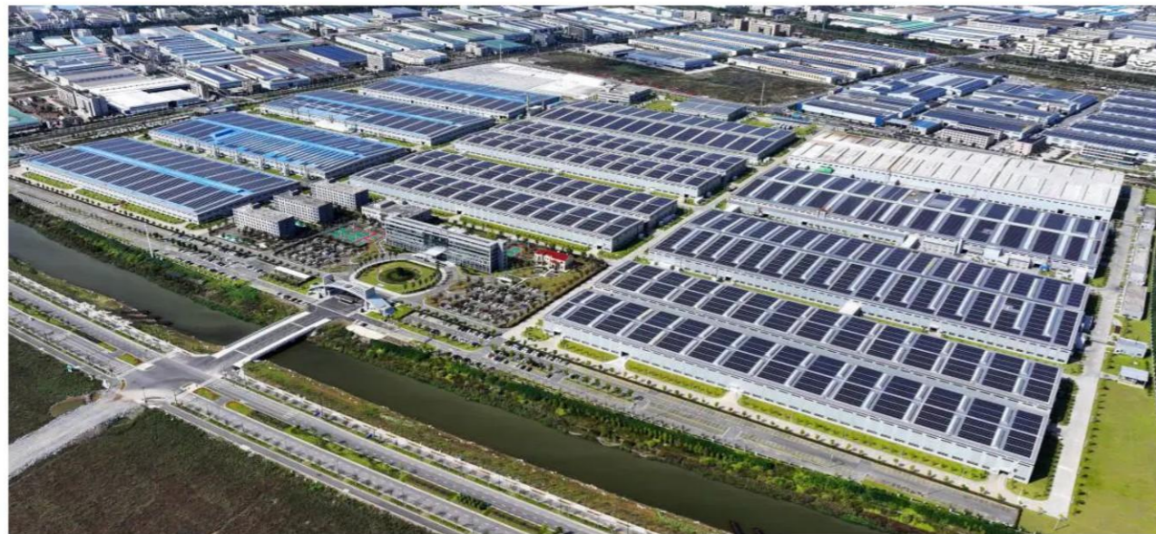
▲ 铭岛铝业有限公司屋顶光伏项目二期工程
